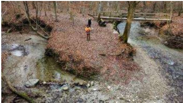
L'embouchure du Blacon s'érode et pourrait menacer à long terme l'appui en rive gauche de la passerelle
