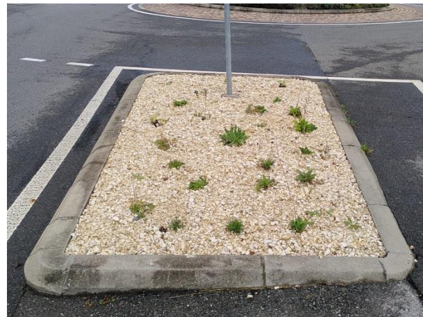
Figure 9 : Délaissé nouvellement réaménagé.
